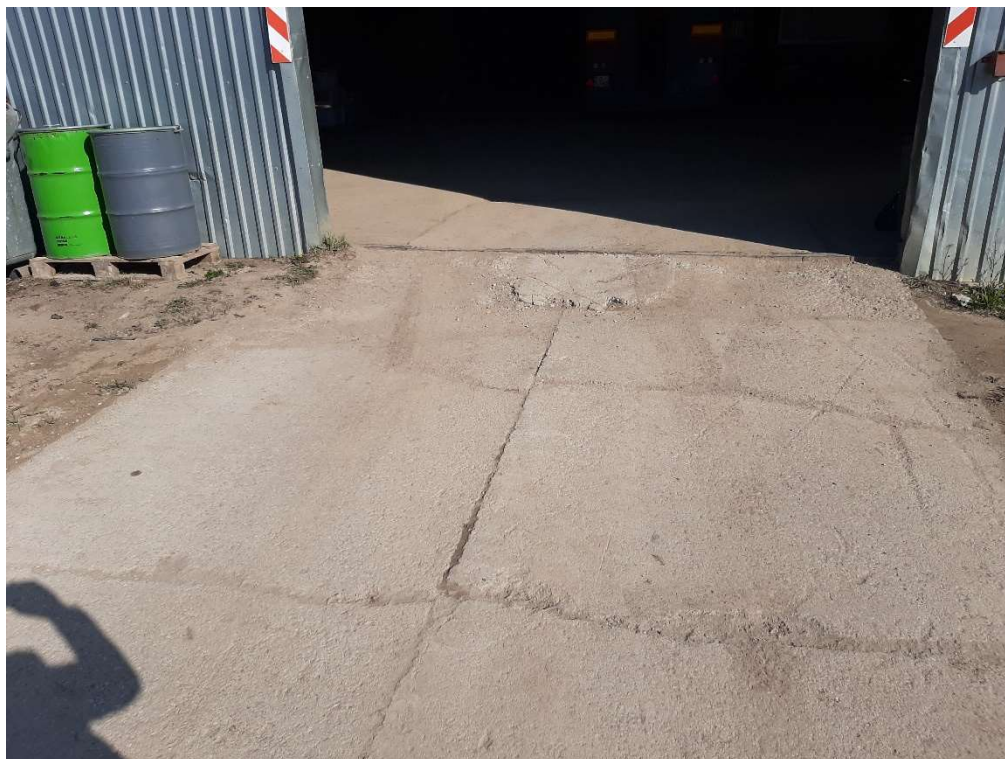
Att.3 - Garāžas iebrauktuves remonts
