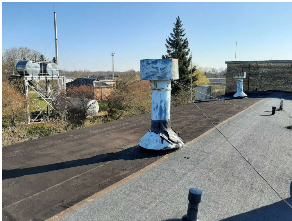
Att.1 - Operatoru ēkas kausējuma jumta seguma remonts
