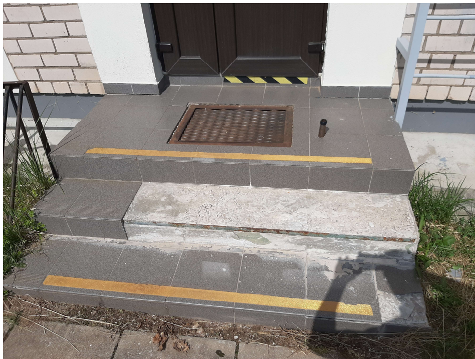
Att.1 - KMI ēkas lieveņu remonts
