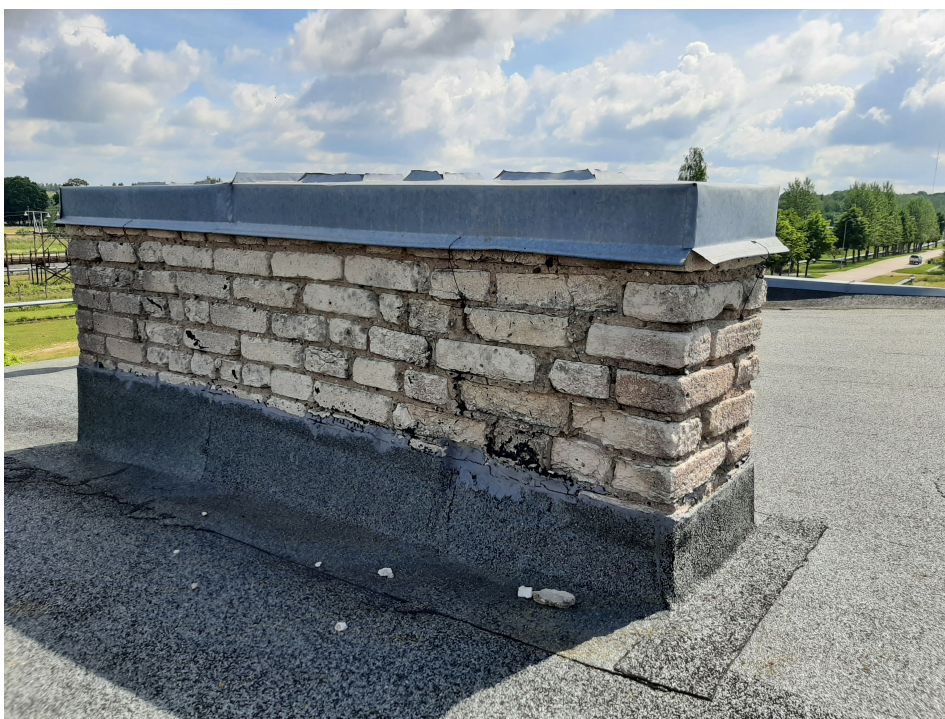
Att.2 - Katlu mājas jumta ventilācijas šahtas remonts
