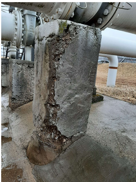
Att. 1 - Aizbīdņa Nr.62 pamata remonts
