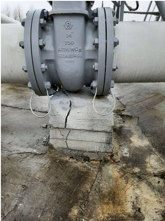
Att. 5 - Aizbīdņa Nr.128 pamata remonts
