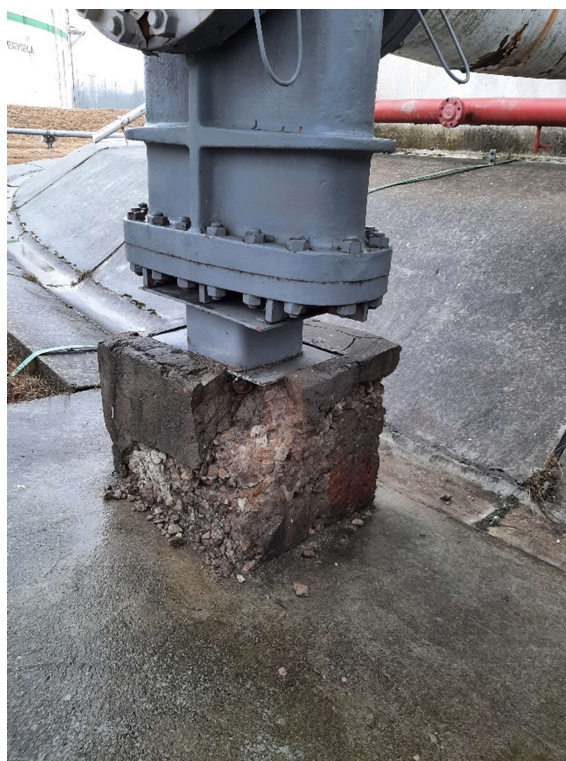
Att. 2 - Aizbīdņa Nr.113 pamata remonts
