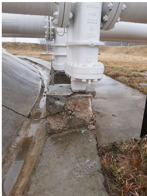
Att. 3 - Aizbīdņa Nr.97 pamata remonts
