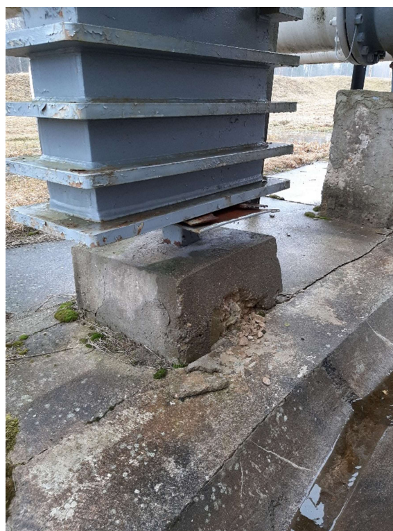
Att. 4 - Aizbīdņa Nr.89 pamata remonts
