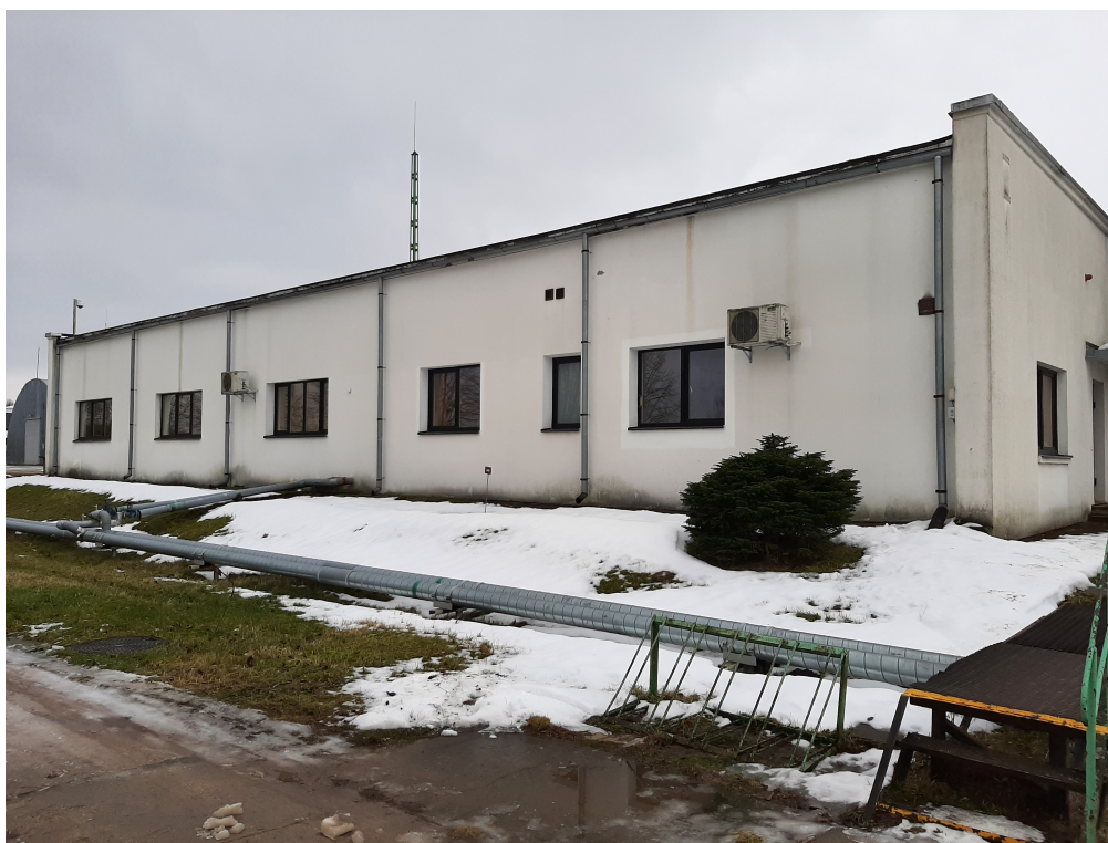
Att.3 Ēka Nr.2 – Elektrocehs
