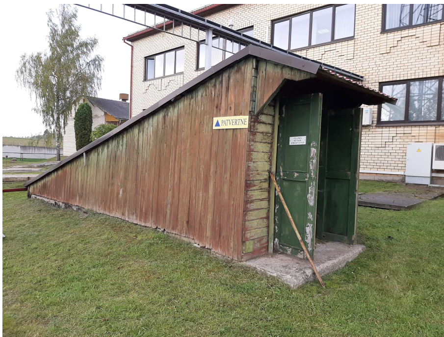
Att.1 Nojumes remontdarbi
