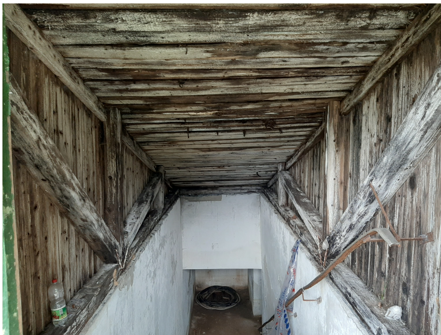
Att.3 Nojumes remontdarbi
