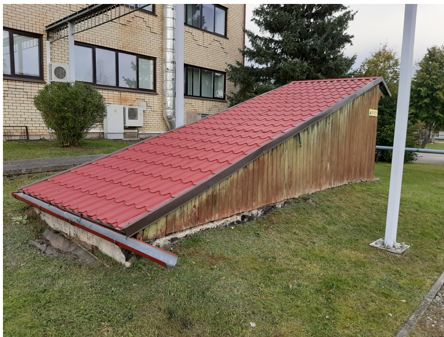
Att.2 Nojumes remontdarbi
