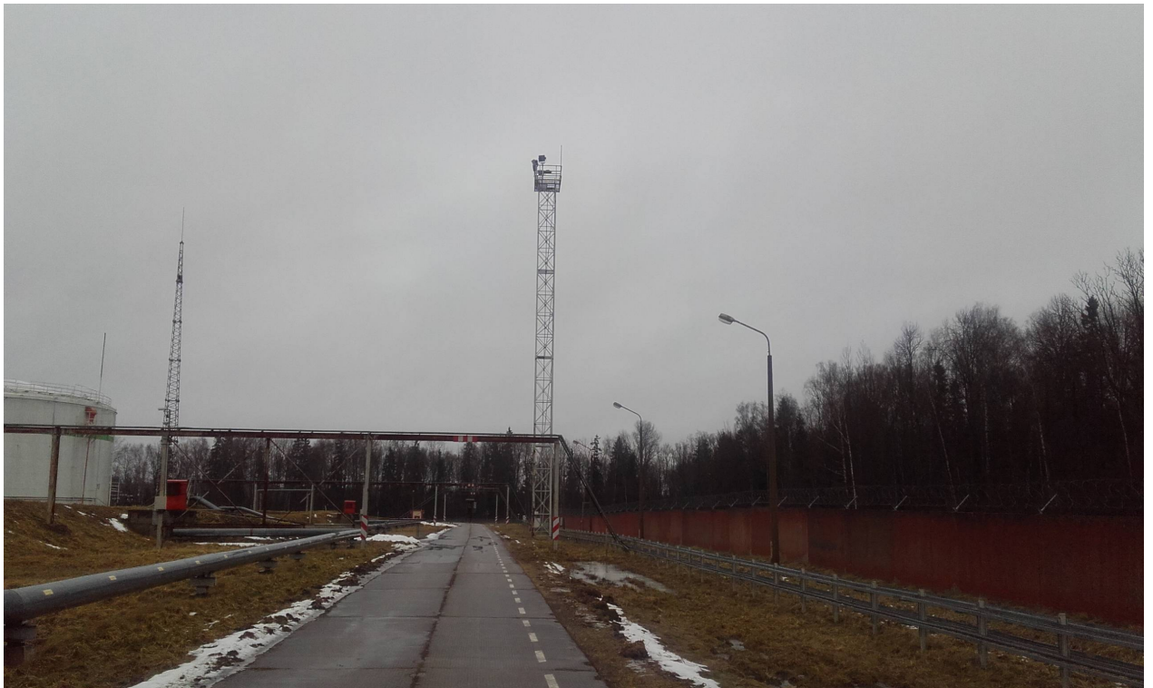
Att.1 - Prožektoru masti
