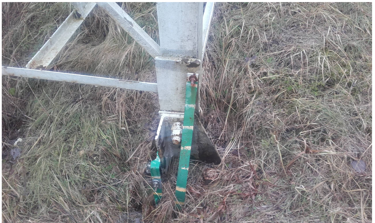
Att.4 - Prožektoru masta zemējuma kontūrs
