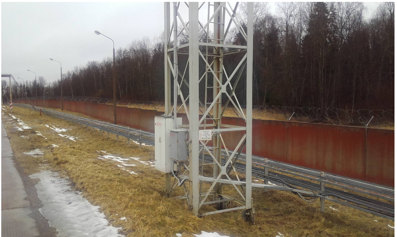
Att.2 - Prožektoru masta tērauda konstrukcijas
