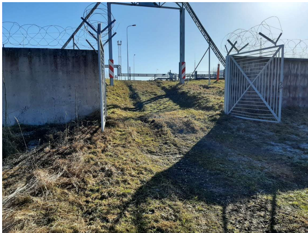
Att.1 Rezervuāru parka rezerves iebrauktuves asfaltēšanas darbi
